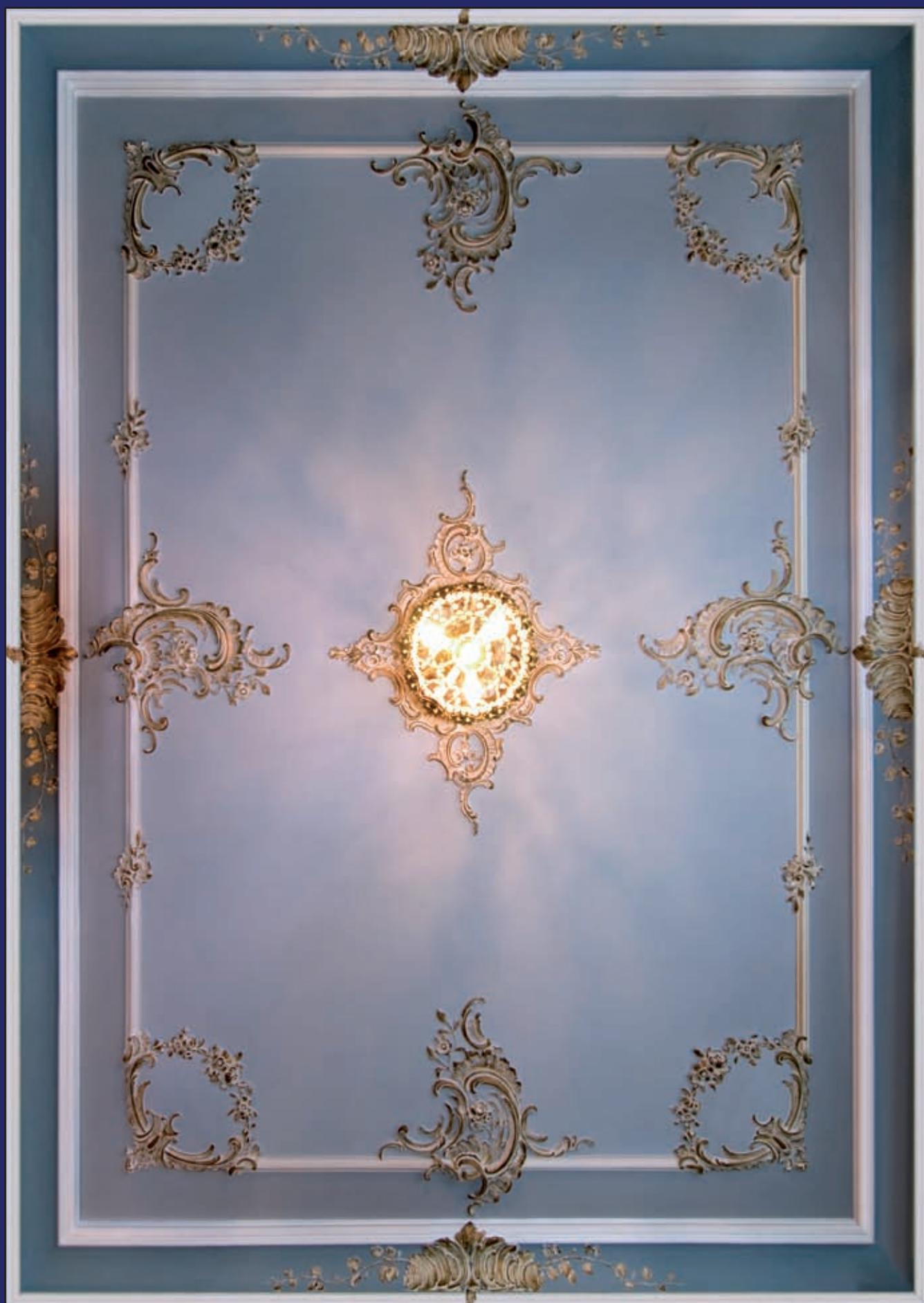
Fertige Stuckdecke aus Stuckgesims Nr.846 und Nr.846 D. Inneres Deckenfeld aus Stuckleiste Nr.873 mit den Dekorecken Nr.873 E2 und den kleinen Mitteldekoren Nr.873 M. Die großen Mitteldekore sind handgefertigte Sonderanfertigungen. Rosette Nr.9620.
