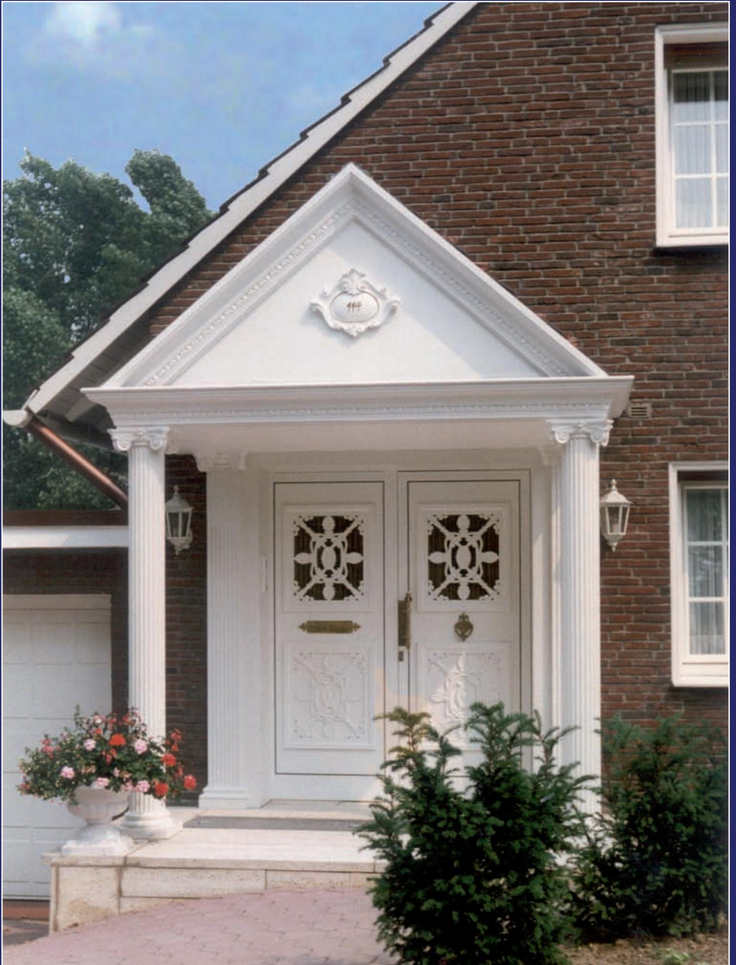
Klassische Eingangsgestaltung aus Pilastern Typ 563, den passenden Säulen vom Typ 552 sowie den Giebelgesimsen Nr.8879 und Nr.808. Die Kartusche Nr.6604 mit eingravierten Ziffern dient hier als Hausnummer.
